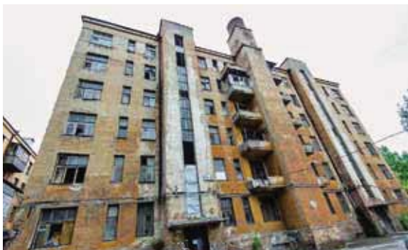
Иллюстрация 2. Один из корпусов Городка милиции 1932 г., ул. Чапаева, 14. Архитектор не установлен. Фото А. Устюжанина (ноябрь 2017 г.)
