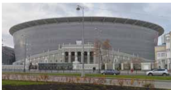
Иллюстрация 5. Объект культурного наследия регионального значения. Стадион «Центральный». Комплекс. 1957 г. Арх.: С. А. Васильев, Ю. А. Владимирский, г. Екатеринбург (Екатеринбург Арена) (источник — сайт www.e1.ru )
