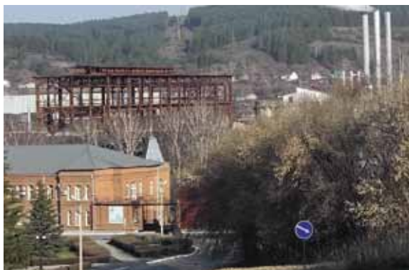
Иллюстрация 2. Комплекс металлургического завода. Белорецк. Фото Т. Ю. Быстровой. 2017 г. Все здания завода находятся под горой, тогда как основная часть города расположена выше
