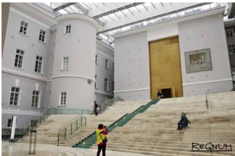
Иллюстрация 6. Музейный комплекс Эрмитажа в здании Главного штаба на Дворцовой площади в Санкт-Петербурге. Архитектор Н. И. Явейн
