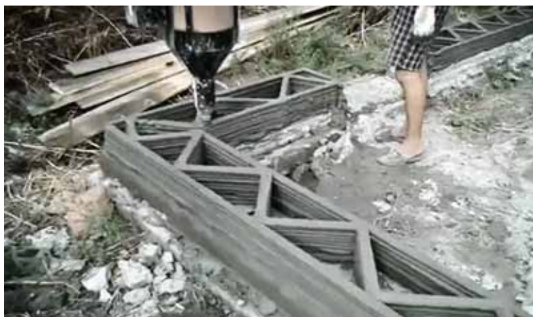
Иллюстрация 5. Процесс возведения вертикальных несущих конструкций производителем бетонной смеси, предоставившим материалы для испытаний. Источник: сайт «3Dtoday» [Электронный ресурс]. URL: http://3dtoday.ru (дата обращения: 20.05.2018)
