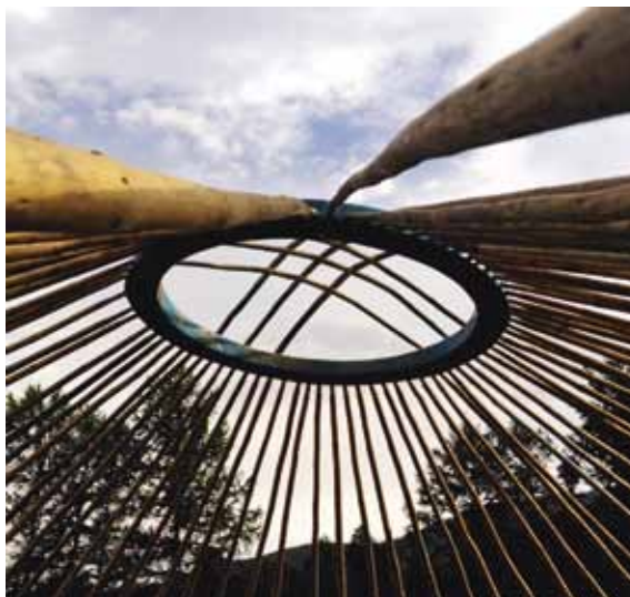
Иллюстрация 1. Конструкция для купола тувинской юрты. Фото М. С. Кухта
