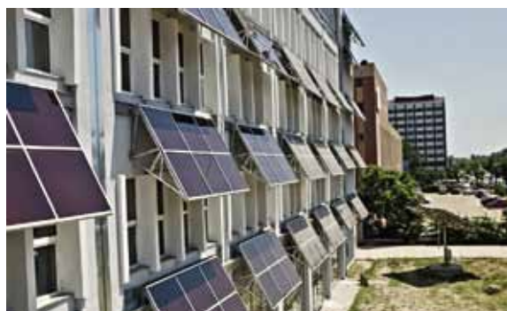
Иллюстрация 9. Фасад здания с элементами солнечных панелей. Источник: http://solarcanopy.co.uk/page10/photos-4/files/page5-1003-full.html (дата обращения: 14.04.2019)
