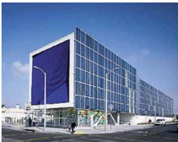
Иллюстрация 7. Интегрирование солнечных батарей в ограждающие конструкции зданий: слева — средняя школа Green Dot Animo в Inglewood. Лос-Анджелес, США, с солнечными батареями на фасаде. Арх.: бюро Brooks + Scarpa. Источник: http://wordscience.org/shkola-los-andzhelesa-poluchila-gigantskuyu-solnechnuyu-stenu-green-dot.html (дата обращения: 14.04.2019); справа — ферма с кровлей из солнечных панелей. Источник: http://zvz.abok.ru/articles/35/ (дата обращения: 14.04.2019)
