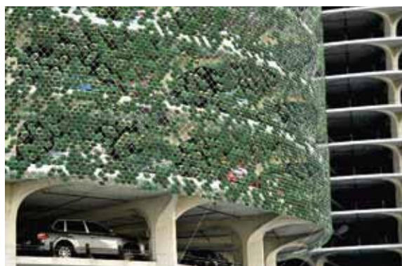
Иллюстрация 10. Элементы системы Solar Ivy на фасаде здания. Арх.: компания SMIT. Источник: https://inhabitat.com/wp-content/blogs.dir/1/files/2011/06/Solar-Ivy-Update-11.jpg (дата обращения: 14.04.2019)
