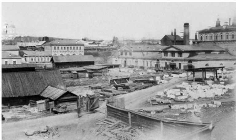
Иллюстрация 2. Вид на Билимбаевский завод. На фото слева направо расположены здание столярной и слесарной мастерской, здание заводской лаборатории, театра и склада, здание доменного цеха и кричной фабрики. На заднем плане: храм Святой Троицы, господский дом и заводская контора. Фото 1894 г. Автор не известен. Архив музея истории архитектуры и дизайна, Екатеринбург
