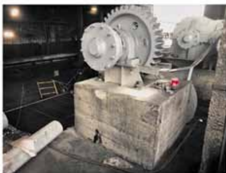
Иллюстрация 6. Общий вид и схема расположения обнаруженных дефектов фундамента привода ротора Ф4. Автор фото и схемы А. В. Куршпель. Август 2019 г.
