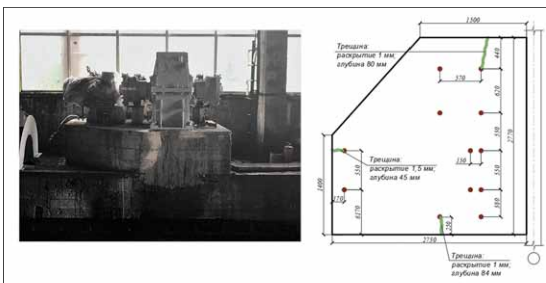
Иллюстрация 4. Общий вид и схема расположения обнаруженных дефектов фундамента привода ротора Ф2. Автор фото и схемы А. В. Куршпель. Август 2019 г.
