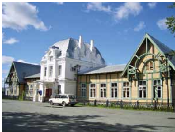
Иллюстрация 2. Ансамбль Верхотурского вокзала. Архитектор неизвестен. Построен в 1906 г. Фото Ю. В. Наливайко. 2012 г.
